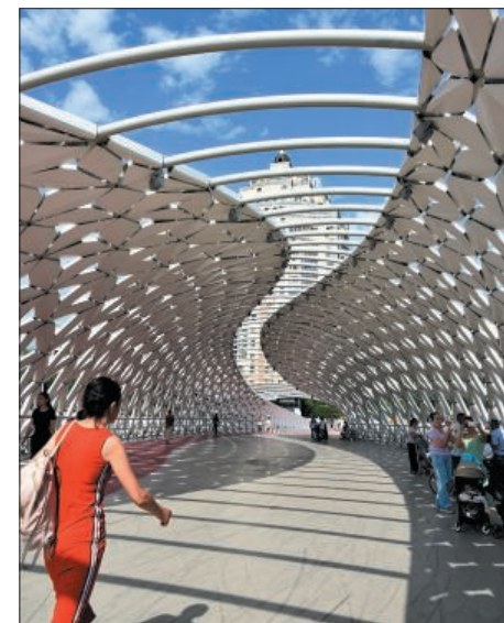
Пешеходный мост через реку Ишим
