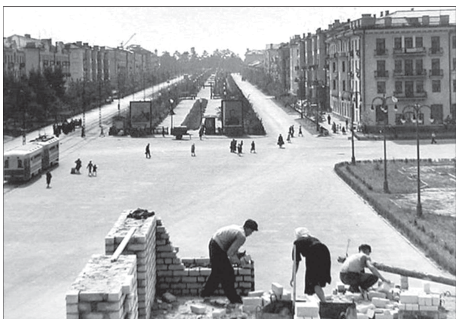
Стройка на проспекте Мира
