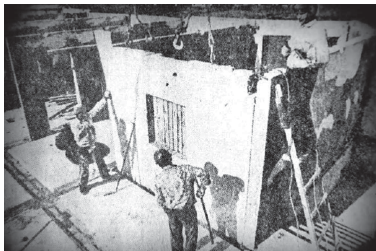
Панельное домостроение — быстро и качественно
