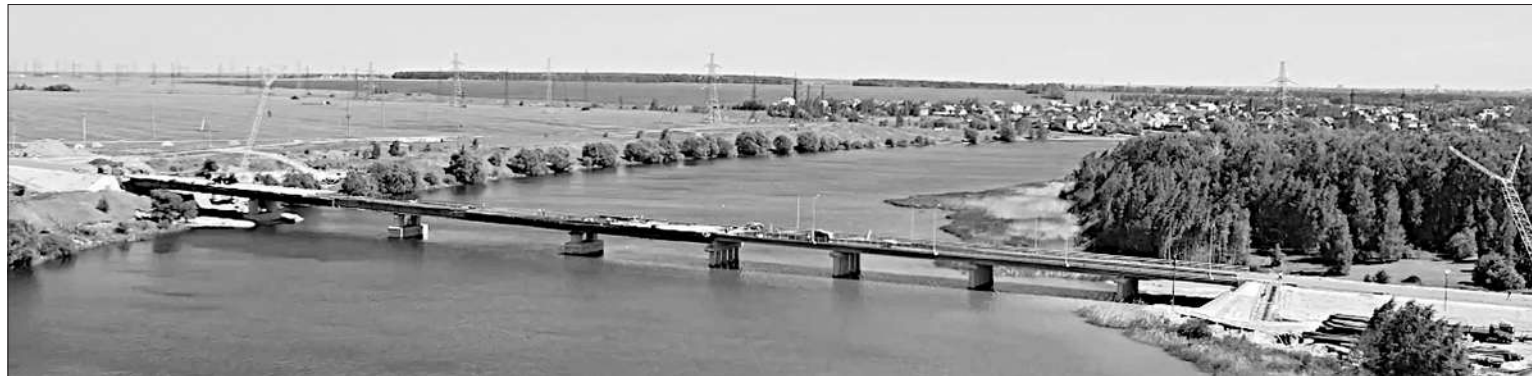
Завершается строительство Липецкой кольцевой автодороги, Восточного обхода Липецка
