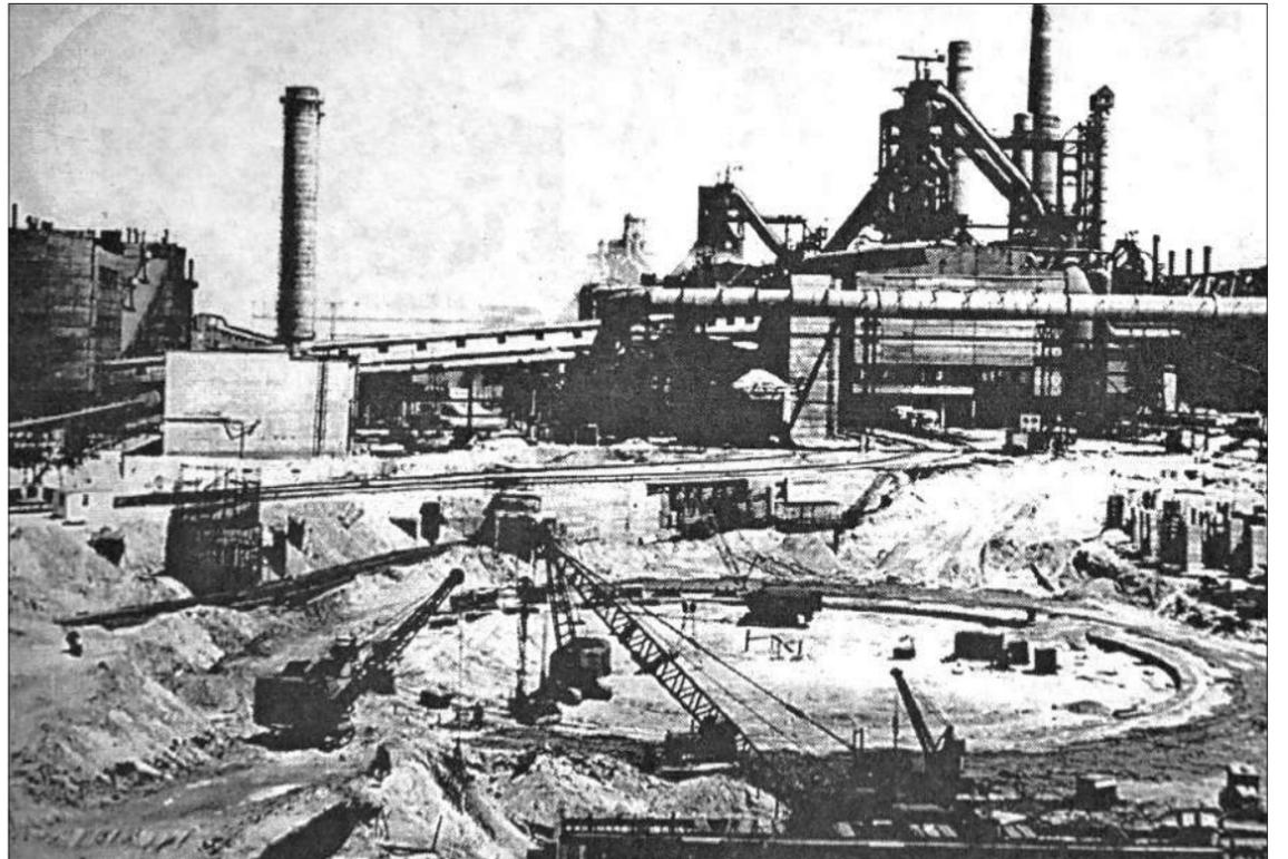
Устройство опорного кольца под опускающей колодец скиповой ямы ДП-5. 1971 год
