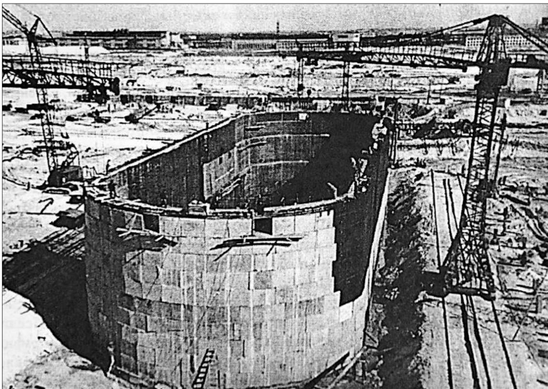
Один из колодцев в процессе опускания и монтажа верхнего яруса. 1964 год
