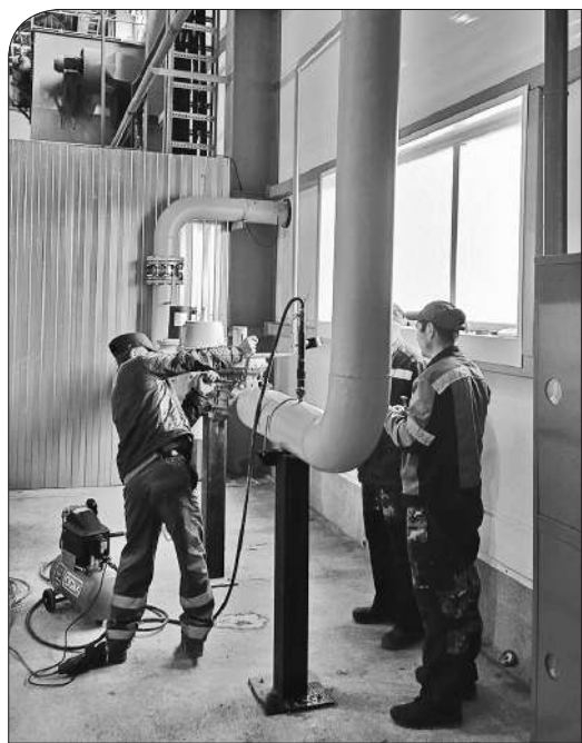
Монтаж оборудования на «Сибу Индастриэл»
