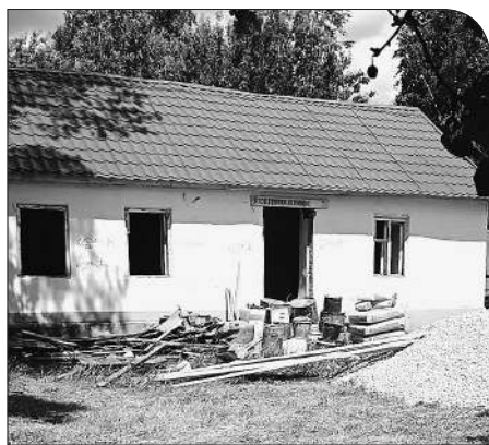
Кровля и наружка готовы, осталась внутренняя отделка. И не скажешь, что здесь были развалины
