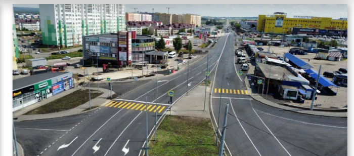
Реконструкция автомобильной дороги г. Пенза – р.п. Шемышейка – с. Лопатино, г. Пенза
