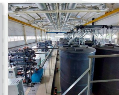
Реконструкция Южной водопроводной станции №2, г. Калининград
