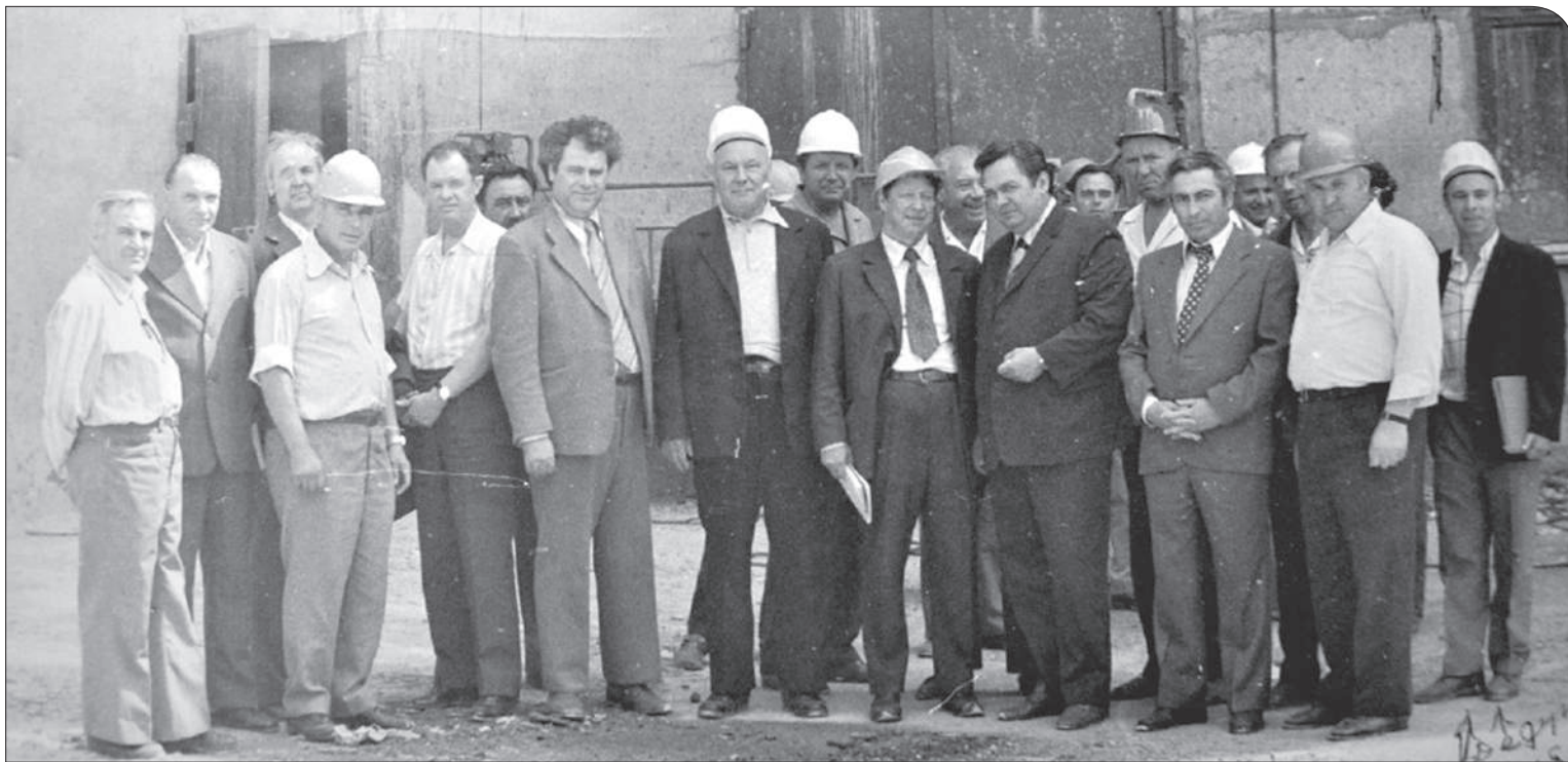
Приезд министра на строительство Добринского сахарного завода. Белоус крайний справа
