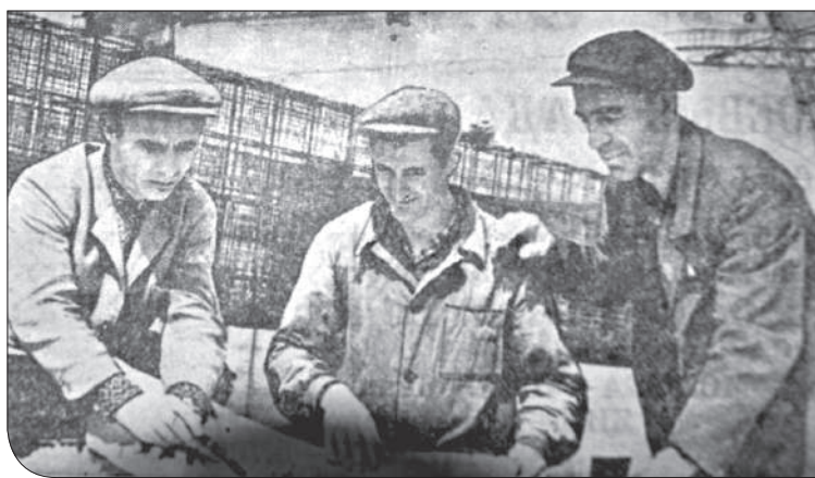
Фото из областной газеты: Белоус (слева) на строительстве кислородно-конверторного цеха
