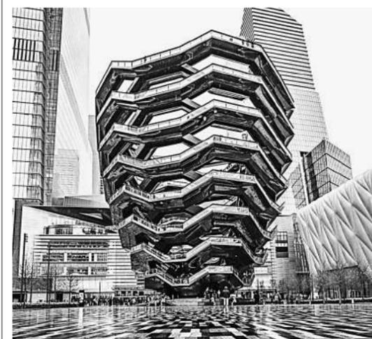
**Vessel («Сосуд»)** — конструкция в Нью-Йорке, возведённая в рамках проекта реконструкции района на Манхэттене. Состоит из 80 обзорных площадок и 154 лестничных пролётов. Открыта 15 марта 2019 года. Форма: перевёрнутый конус из переплетённых лестничных пролётов и горизонтальных площадок. У основания диаметр конструкции 15 метров, постепенно расширяясь к верхушке высота сооружения достигает 277 метров. Общий вес — 600 тонн. Проект разработан дизайнером Томасом Хатервиком.
