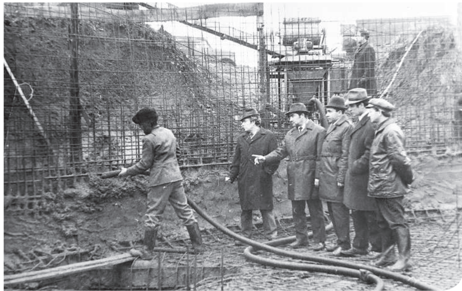
Владимир Манюхин (третий справа) на стройплощадке
