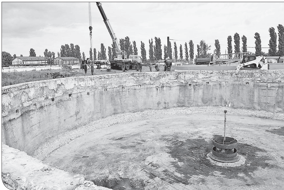
Один из объектов реконструкции на территории грязинского Водоканала
