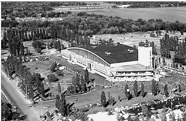
Манеж — вид снаружи и изнутри
